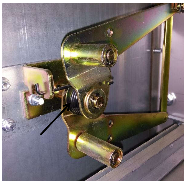
Рисунок 11 - Консервация оси вращения, пружины штанг шторочного механизма
