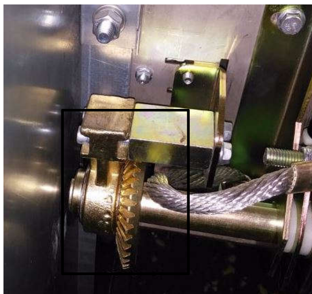
Рисунок 10 - Консервация шестеренчатой пары заземляющего разъединителя
